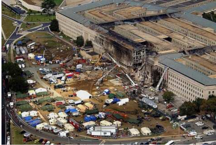
Foto: DOD Die Westseite des Pentagon wird extrem beschädigt.
